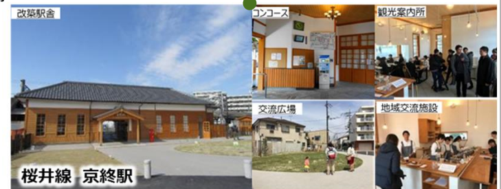
改築した駅舎に地域交流施設や観光案内所を併設
