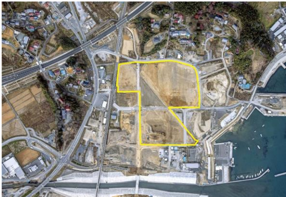
被災市街地復興土地地区画整理事業(松崎片浜地区)
