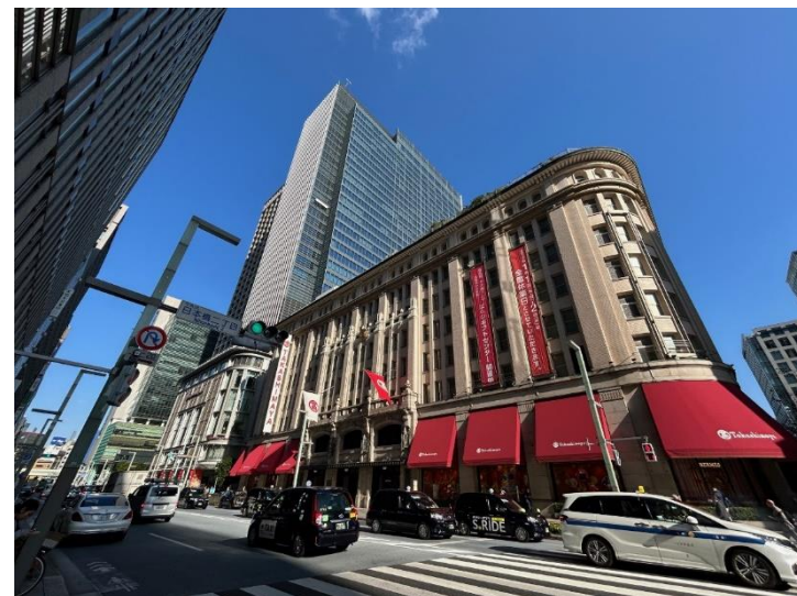
重要文化財の保全・利活用(日本橋高島屋)
