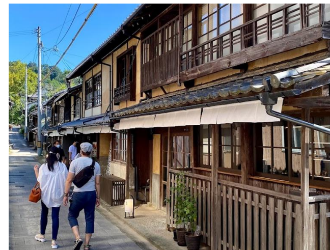
▲ まちに回遊性が生まれた （1階は店舗・2階はホテル客室）
