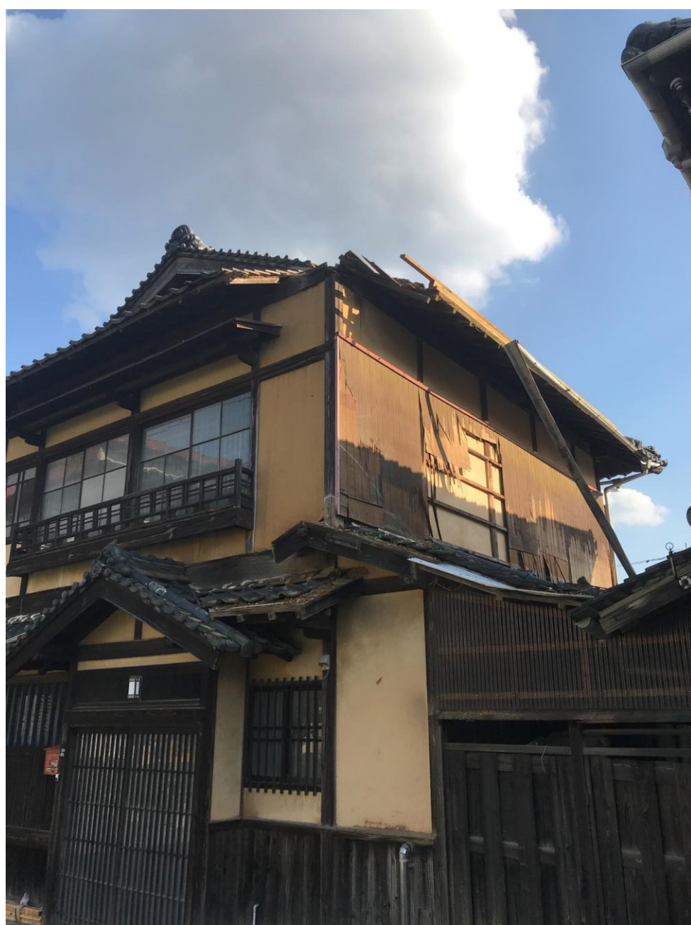
屋根が落ち、建物内部にも雨漏りがあり、老朽化が著しい。
