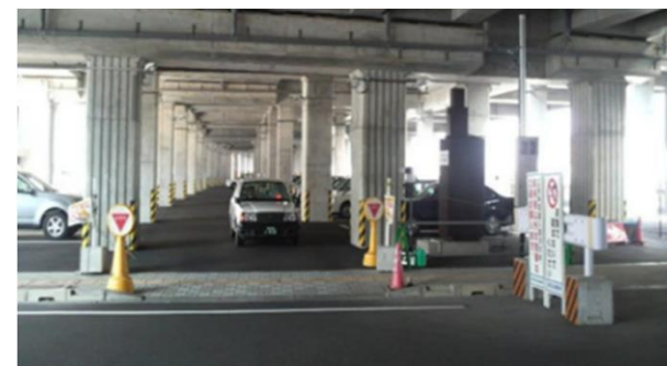
図 高架下を活用したタクシープール 出典) 駅まち再構築事例集(R2.7)
