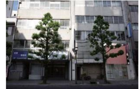
老朽化した空きビルの散在
