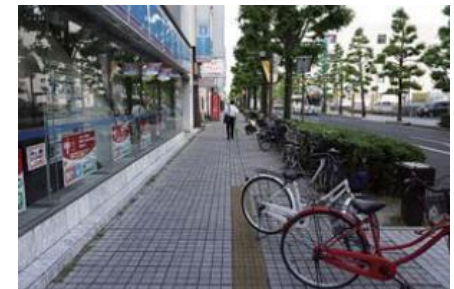
幅員が狭い歩道・ 段差のある車歩道間
