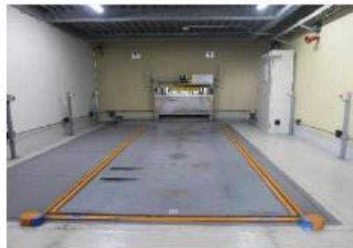
・車椅子利用者対応の機械式駐車装置の例（フルフラット化）
