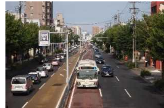
図 道路中央車線にバス優先レーンを整備した 「中央走行方式」(名古屋基幹バス)
