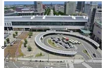
図 交通施設再配置によるバリアフリー化と交通結節機能強化(富山駅) 出典)富山駅周辺整備事業の概要
