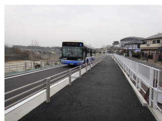
専用道と歩道間に防護柵を設置
