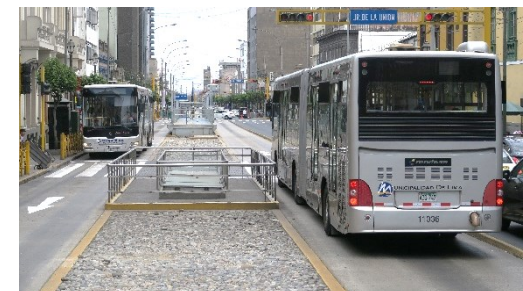
図：一部区間が一般道路と同一平面構造 となっているペルー・リマ市のBRT（メトロポリターノ）
