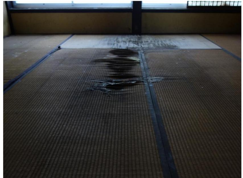
屋根が落ち、建物内部にも雨漏りがあり、老朽化が著しい。
