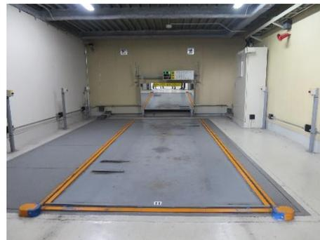
・車椅子使用者対応の機械式駐車装置の例（フルフラット化）
