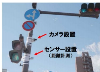
センサー及びカメラの設置状況（前橋市）
