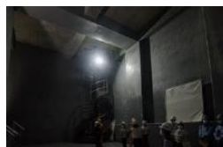
雨水貯水施設
