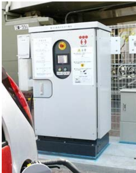
図4-29 パーキングエリアに設置された電気自動車用急速充電器
