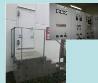
【地下電源への 防水扉設置や高上げ】
