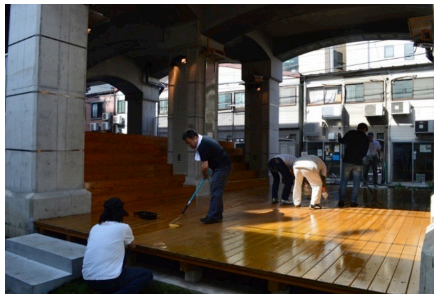
地域住民有志による塗装作業
