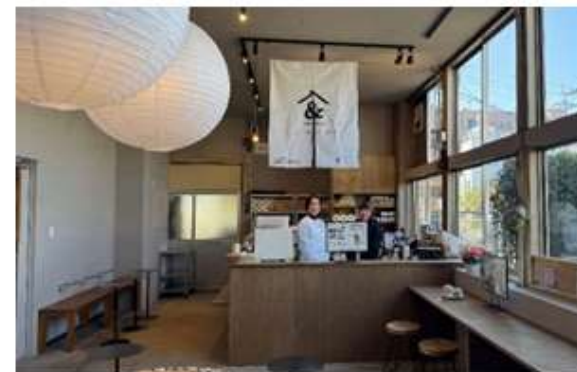
カフェ用のキッチン新設
