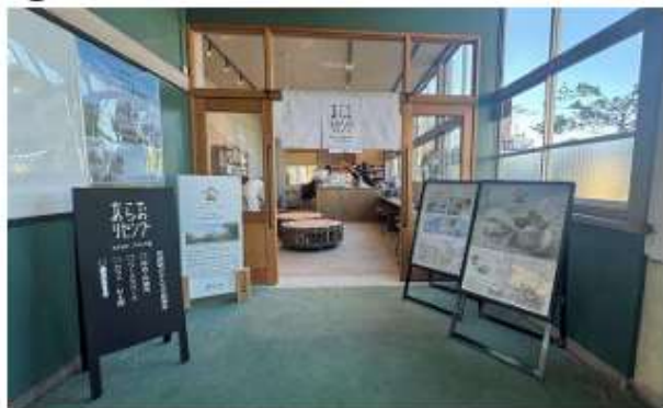
扉の新設と壁面を床に合わせて塗装
