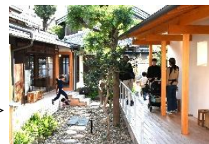
既存建築物のリノベーション (大阪府守口市)
