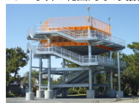
津波避難タワー
