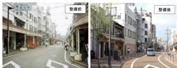
老朽化アーケードの撤去例
