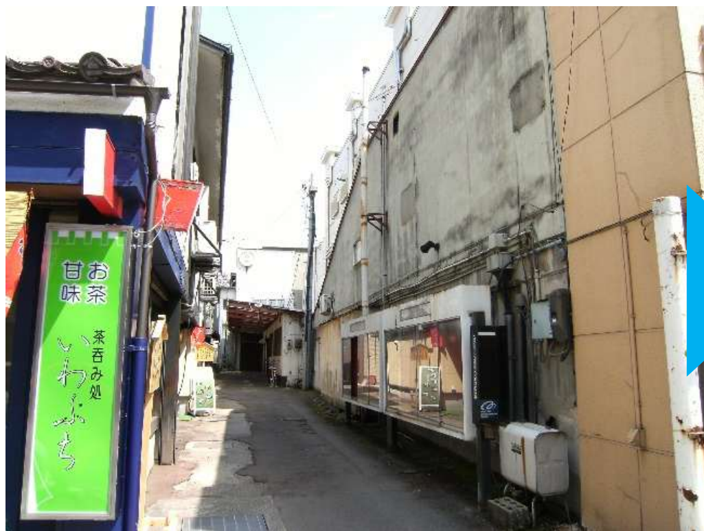
高度経済成長期に暗渠化された御殿堰
