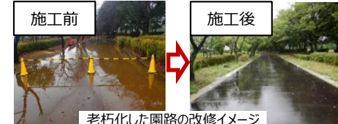
老朽化した園路の改修イメージ
