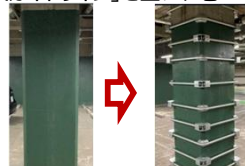
柱の耐震補強
