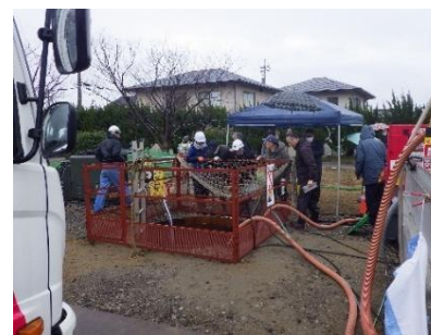
実証実験住民説明会の様子 (石川県羽咋市)
