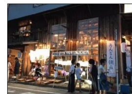
鵜飼屋地区の旧木材倉庫の改修 (岐阜県岐阜市)
