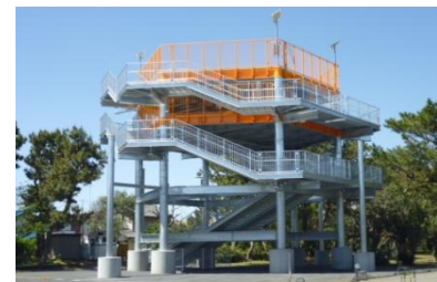
津波避難タワー
