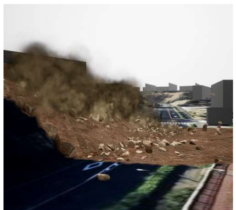
土砂災害の被害状況
