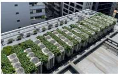
ウノサワ東急ビル（東京都渋谷区） 屋上での取組の様子
