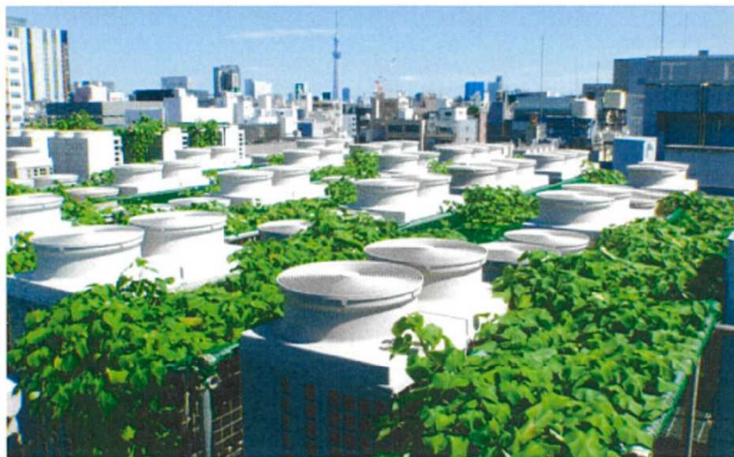
繁茂状況（住友商事 美土代ビル屋上）
