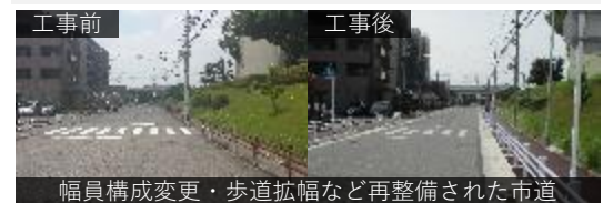
幅員構成変更・歩道拡幅など再整備された市道
