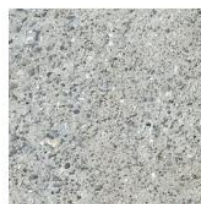
広場、実験ヤード区画通路： コンクリート舗装 (洗い出し仕上げ)
