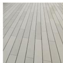
デッキ： 再生木デッキ (グレー系)
