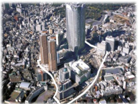
六本木ヒルズでは、震災後もCGSにより電力を確保
