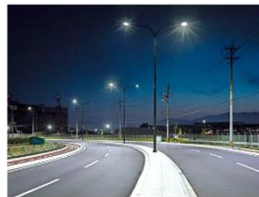
LED照明 (消費電力約56%削減)
