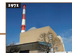
札幌冬季オリンピック開催を契機に地域熱供給が導入され、都心の都市環境が改善されました。
