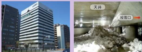
札幌エネルギー供給公社エネルギーセンター (1989年～)
