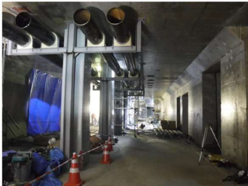
地下歩道天井への導管整備
