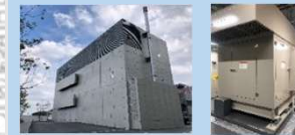
4 6 エネルギーセンター (2019年～)
