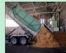
中央エネルギーセンター (1971年～)
