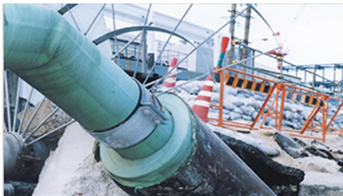
※阪神・淡路大震災時、橋梁崩落後も供給を継続した中圧ガス導管
