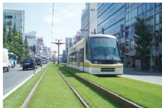
既設の路面電車の軌道敷を芝生化した鹿児島市市電 提供:鹿児島市
