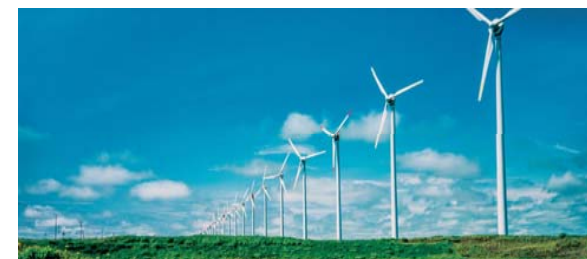
風力発電設備の例
