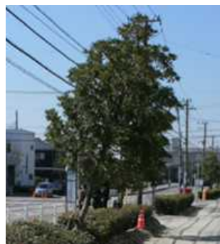
地震液状化による傾斜 8)
