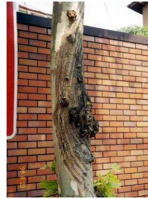
プラタナスの永年生幼腫による腐朽 10)
