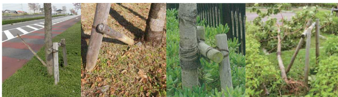
写真 支柱の損傷 3)
