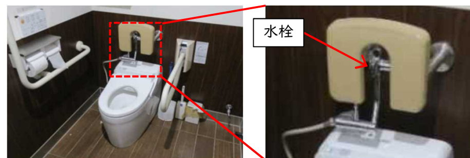
簡易型オストメイト用設備 (腰掛便座の背もたれに水洗をつけたもの) (建築設計標準より)
