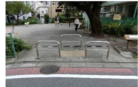
【複数列配置】車止めの配置の仕方によっては、車椅子が通行できない
