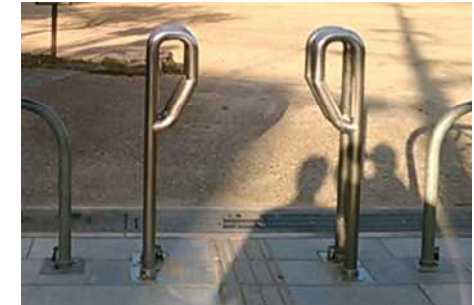
【P型ゲート】上部の突出部分が大型車椅子、ベビーカーなどに引っ掛かって通行できない
