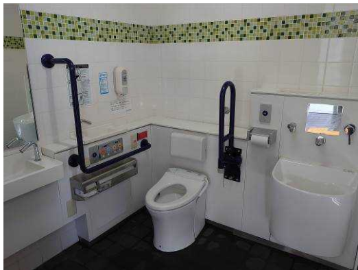
男女共用のバリアフリートイレ 床面や手すりと便器のコントラストが明確になっている。オストメイト用設備として汚物流し、鏡、ペーパー等がある。
