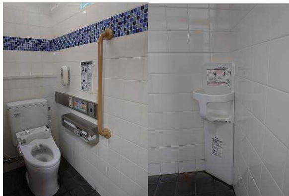
ベビーカーが入れ、ベビーチェアもある 男性トイレの一般便房 女性トイレにも同様の機能がある。
