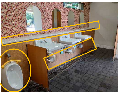
手すりを設け、車椅子使用者の膝が入るスペースを確保した洗面器、手荷物棚、幼児用便器の例 床面や壁面と設備のコントラストが明確になっている。
