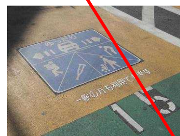
◇舗装面の標示
