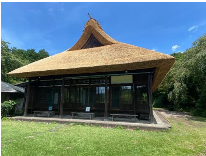
修復完了後の茅葺屋根母屋
