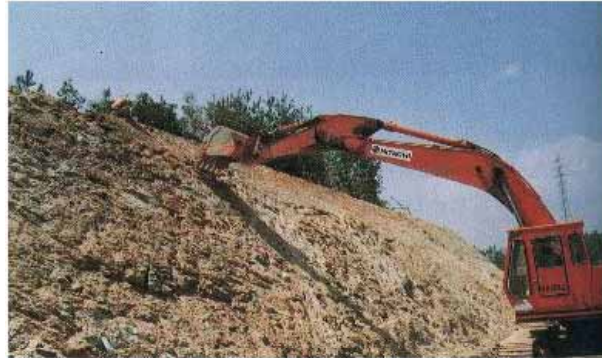
法面整形（切土部）の施工例【出典：改訂3版土木施工の実際と解説】
