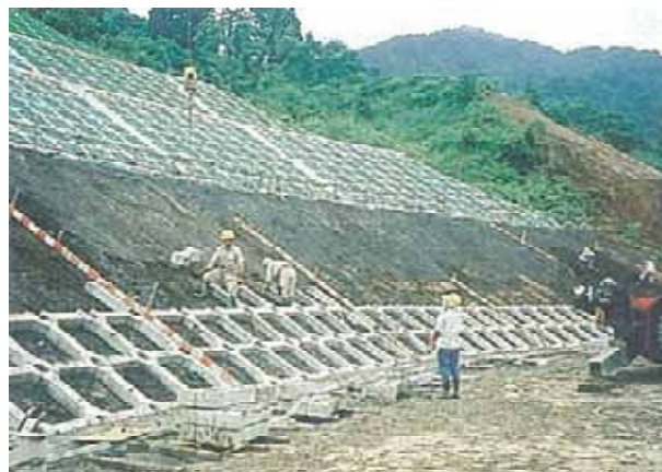
プレキャスト法枠布設状況【出典：改訂3版土木施工の実際と解説】
