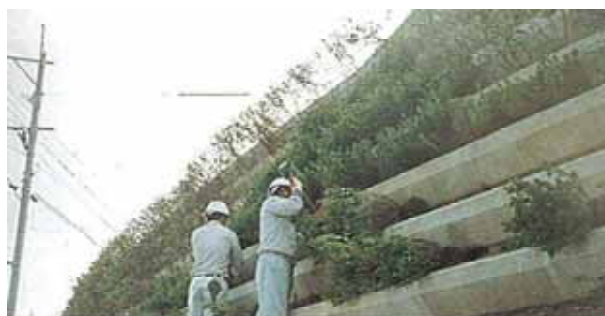
植樹工の例【出典：改訂3版土木施工の実際と解説】
