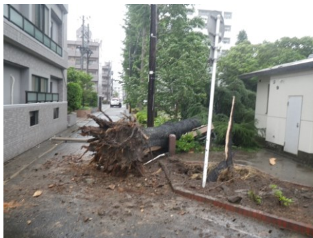
強風で敷地境界付近の樹木が 根本から倒木し、電線引込柱を損傷
