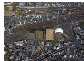
整備前の様子
