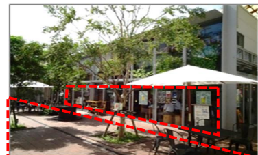
民間事業者による民地部分のオープンスペース化 や建物低層部のガラス張り化等
