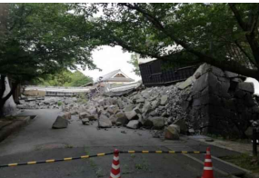
▲熊本城の被災状況
