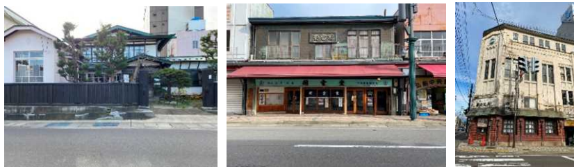
図 36 「趣のある建物」の例（左：旧杉山醫院、中：開雲堂、右：三上ビル）
