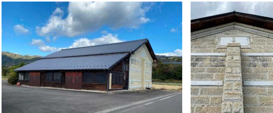
図 61 詳細調査が実施された旧小坂村産業組合石蔵
