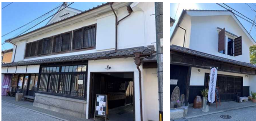
図 53 改修後の旧久富家（左）、旧森永家（右）
