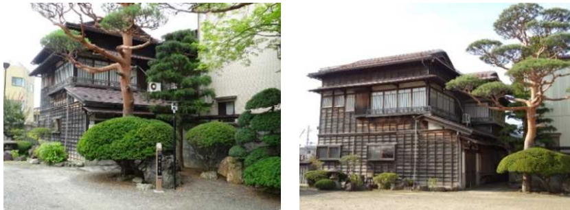
図 70 平成 31 年度の詳細調査対象となった料亭末廣
