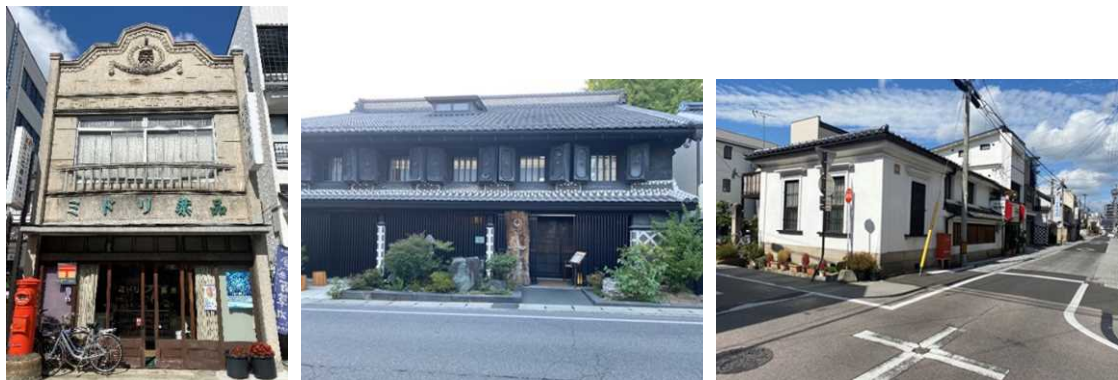
図 40 近代遺産調査の対象となった建物の例
