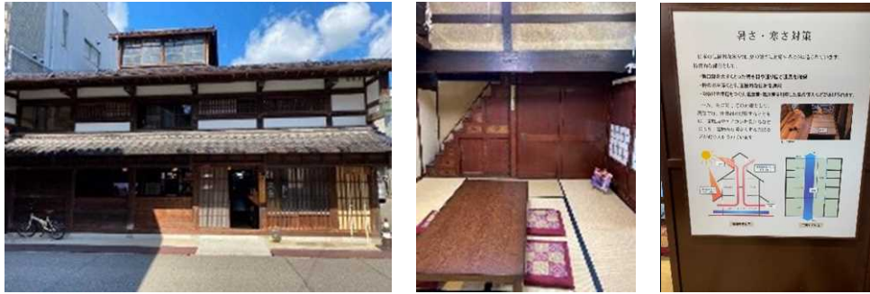
図 9 金澤町家情報館 (左：外観、中：断熱材を施した座敷部分、 右：町家の改修における暑さ・寒さ対策を示したパネル展示)
