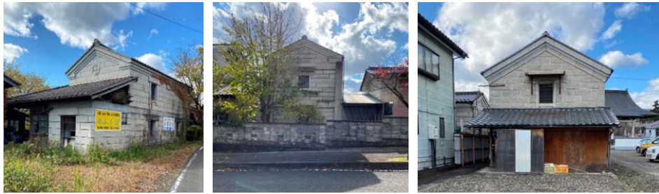
図 56 国見石を使った石蔵の例
