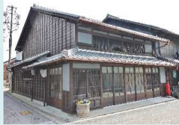
修景され蘇った町家 ▶
