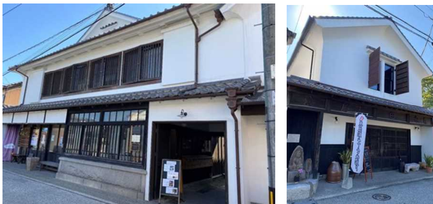
図 53 改修後の旧久富家（左）、旧森永家（右）
