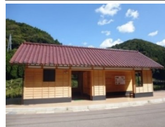
休憩所兼トイレの整備
