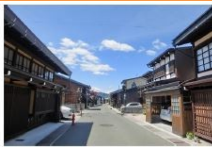
無電柱化と建物の外観修景で刷新された町並み
