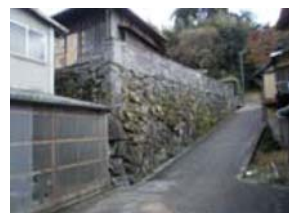
勘兵衛屋敷の石垣 (大洲市 / 未指定)
