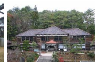
吹屋小学校校舎 (高梁市 / 県指定)
