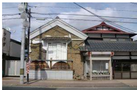
修理・修景前
