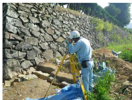
3次元レーザーによる測量
