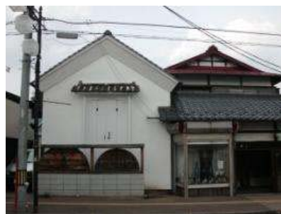
修理・修景後
