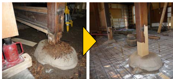
構造の修理の様子 （白蟻被害のあった柱を根継修理）
