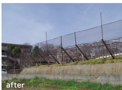
景観に配慮した防風ネットへの交換
