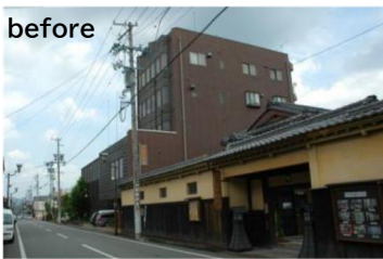
敷地内部に残存する土蔵以外は鉄骨造であった
