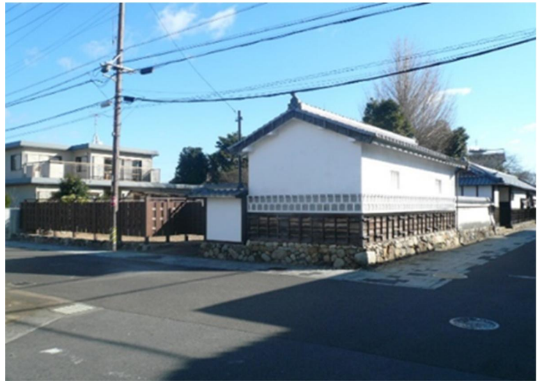
保存・修理後の土蔵(敷地南西側)
