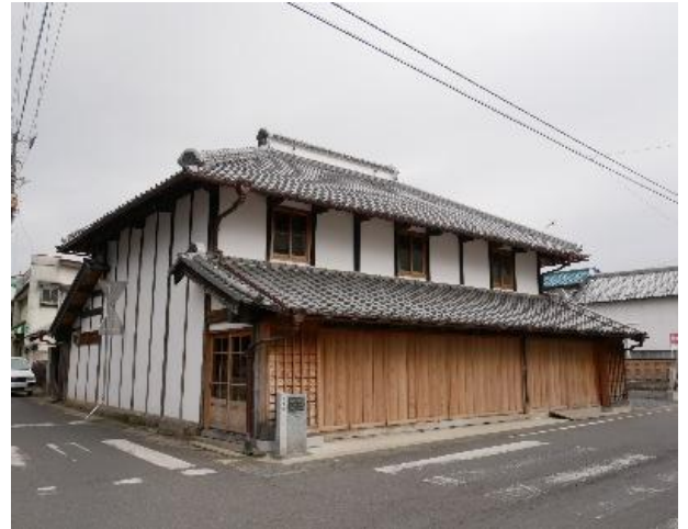
復旧した高久家住宅
