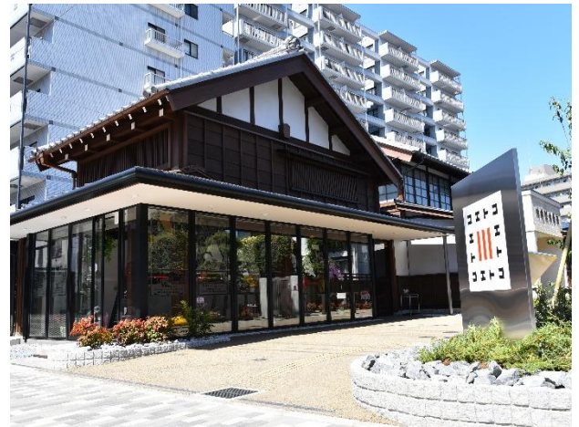
川越市文化創造インキュベーション施設(施設愛称:コエトコ)入口手前の建物は地域との交流の場となるカフェ(新築)
