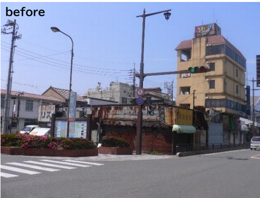
唐樋札場跡に建ち並んでいた老朽化した商業施設
