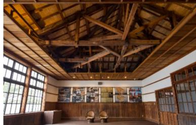
天井裏見学室(本館)
