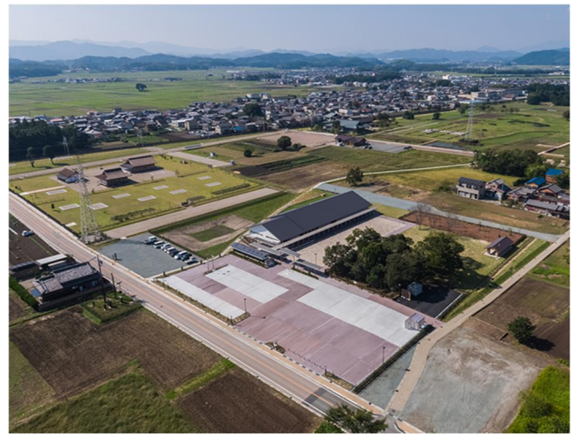
整備状況の全景
