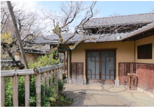
図 旧川端龍子邸(主屋)の外観
